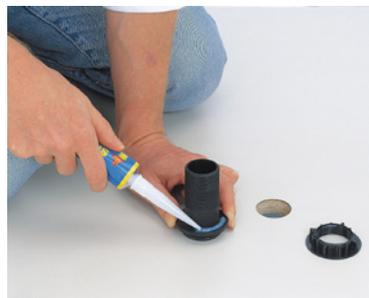
2. DEKAsyl MS-Kraftkleber auf den Stützen der Dachdurchführung auftragen. Stützen in die Bohrung einführen und von unten mit der Rändelmutter fixieren.
